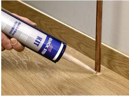
Kitt mit Hilfe einer Spritzpistole in die Fugen einbringen. Kunststoffdüse schräg abschneiden, so dass eine Öffnung mit einem Durchmesser von mindestens 5 mm entsteht. Kitt anschließend in die Fuge einbringen und mit Spachtel glätten. Die Fugen müssen sauber, trocken, staub- und fettfrei sein.
